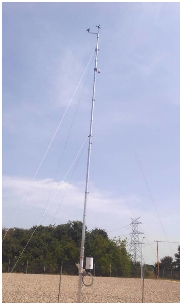
Figure 15: Mât du vent installé capteur de direction du vent orienté vers le nord / Wind mast erected; wind direction sensor orientated to North
