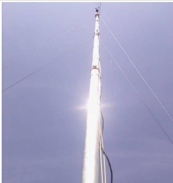
Figure 14: Capteurs de vent installés sur le mât du vent / Wind sensors installed on wind mast
