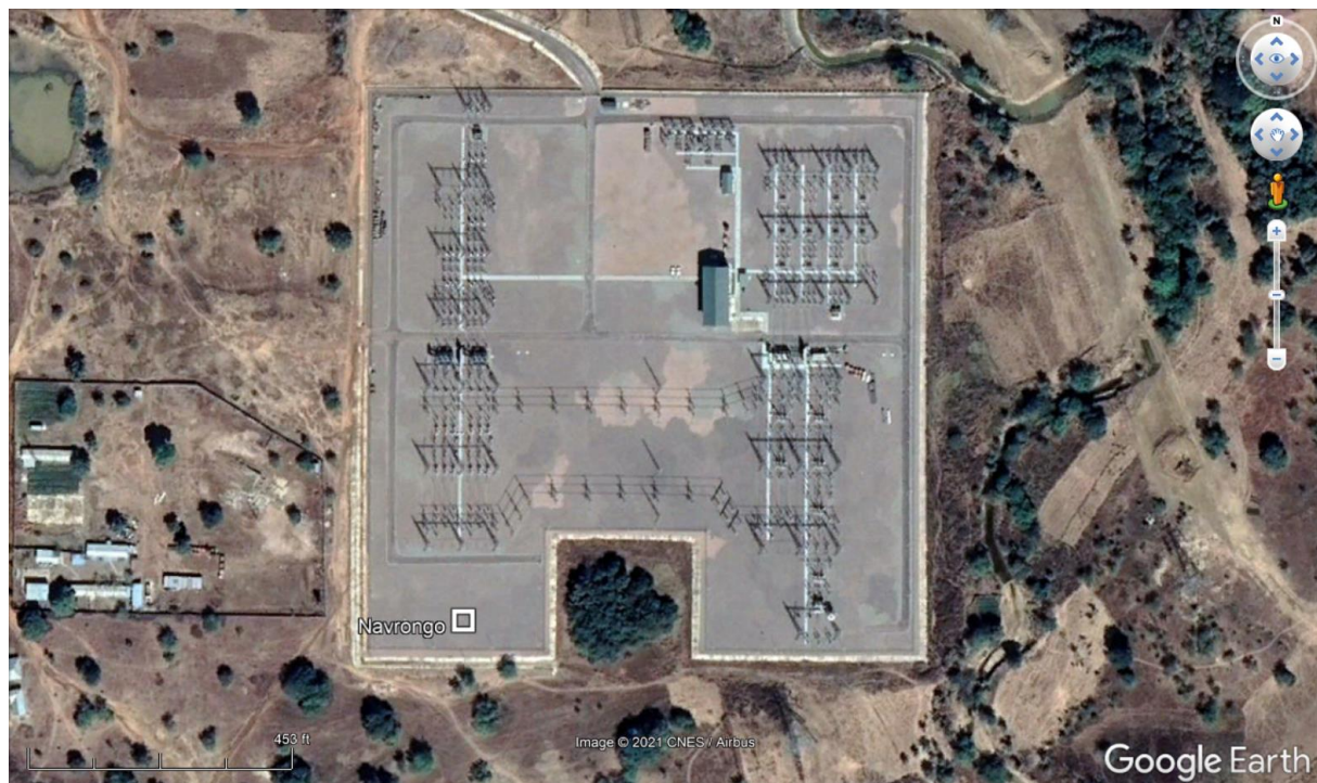
Figure 2: Emplacement dans la sous-station de GRIDCo à Navrongo / Location at the GRIDCo substation in Navrongo.
