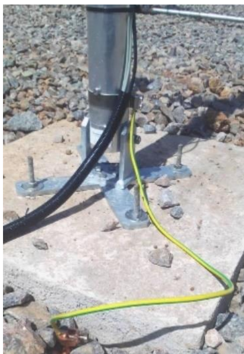
Figure 12 : Fondations du mât du vent, câble de terre fixé au boulon de terre, tube de protection pour les câbles du mât du vent / Wind mast foundations, ground cable fixed to ground bolt, protective tube for wind mast cables
