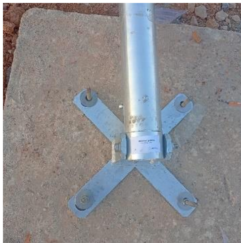
Figure 10 : Fondations du mât du vent / Wind mast foundations
