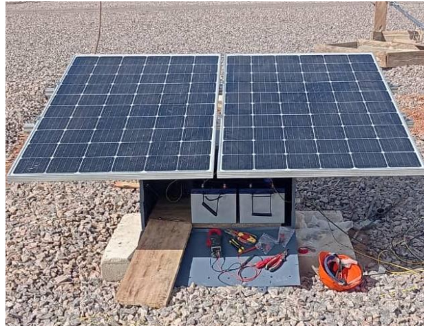
Figure 35 : Système d'alimentation / Power supply PV system
