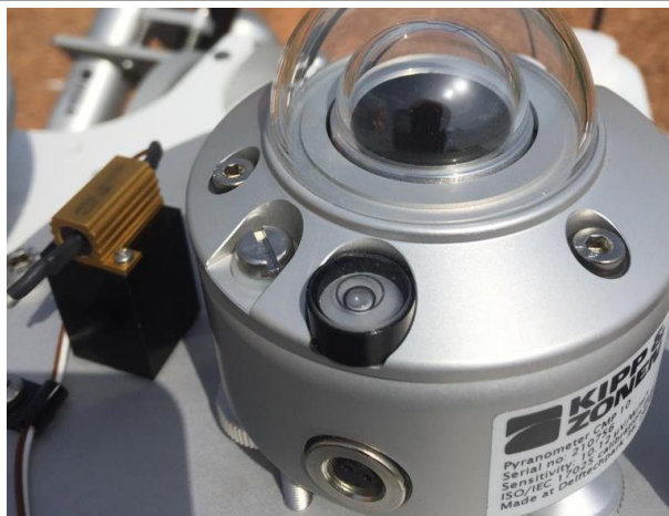
Figure 18: Mise à niveau du pyranomètre CMP10 (GHI) / CMP10 pyranometer leveling (GHI)
