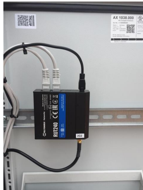
Figure 31: Ruteur LTE / LTE router
