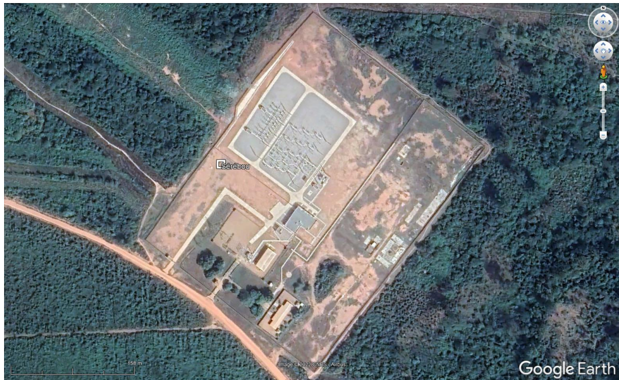
Figure 2: Emplacement dans la sous-station de CI-ENERGIES à Sérébou / Location at the CI-ENERGIES substation in Serebou.
