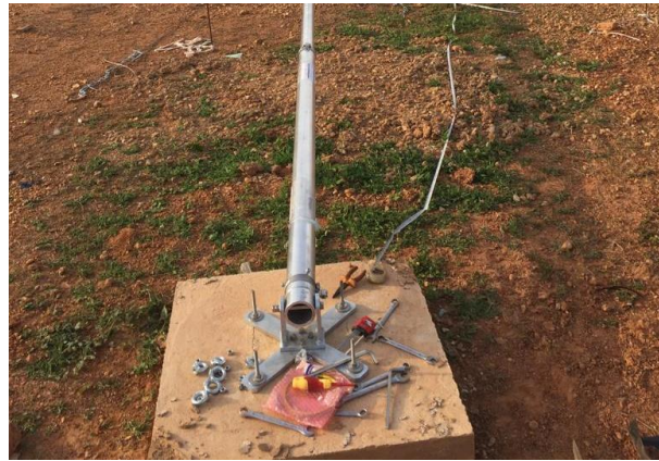
Figure 10 : Fondations du mât du vent / Wind mast foundations
