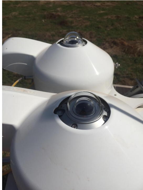
Figure 82: Pyranomètres et ventilations sur le tracker solaire / Pyranometers and ventilation units on solar tracker.
