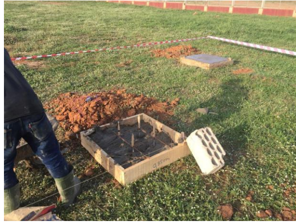
Figure 45 : Fondations du mât du vent / Wind mast foundations.
