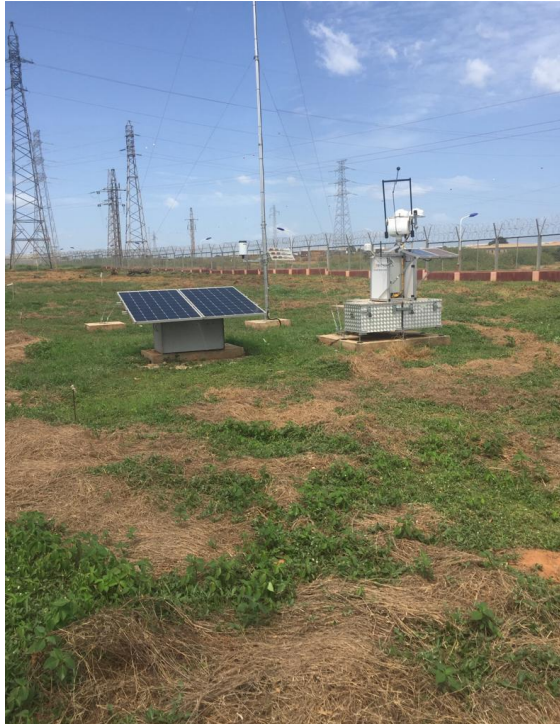
Figure 81: Vue d'ensemble de la station de mesure / Measurement station overview.
