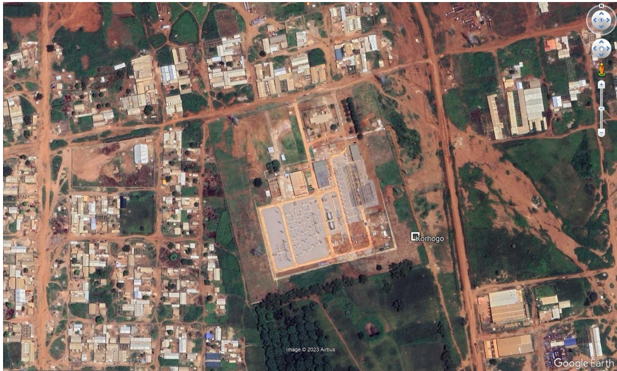
Figure 3: Emplacement dans la sous-station de CI-ENERGIES en Korhogo / Location at the CI-ENERGIES substation in Korhogo.
