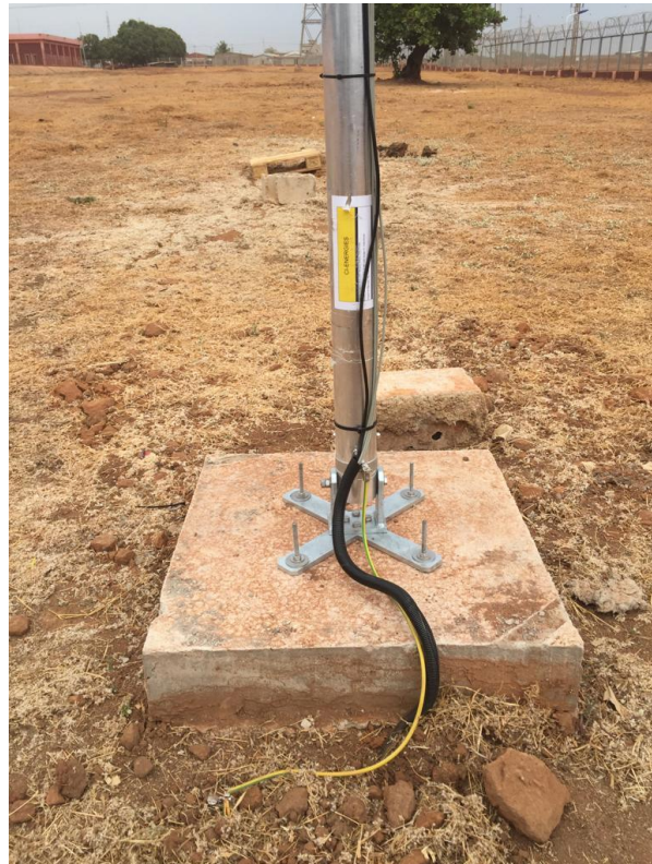
Figure 47 : Fondations du mât du vent, câble de terre fixé au boulon de terre, tube de protection pour les câbles du mât du vent / Wind mast foundations, ground cable fixed to ground bolt, protective tube for wind mast cables.
