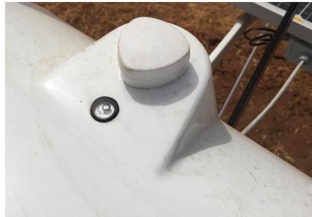
Figure 55: Mise à niveau du tracker / Tracker leveling.
