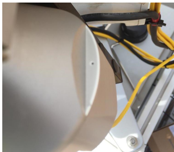
Figure 28 : Alignement du pyrhélimètre / Pyrheliometer alignment
