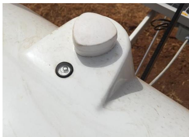
Figure 20: Mise à niveau du tracker / Tracker leveling
