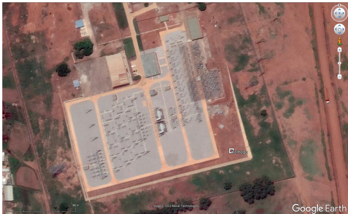
Figure 2: Emplacement dans la sous-station de CI-ENERGIES à Korhogo / Location at the CI-ENERGIES substation in Korhogo.
