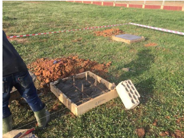
Figure 10 : Fondations du mât du vent / Wind mast foundations
