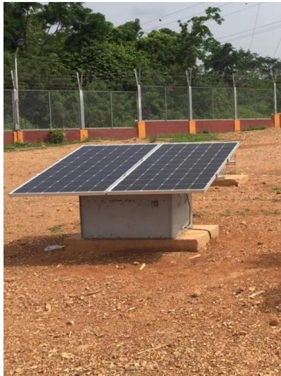
**Figure 70: Système d'alimentation / Power supply PV system.**
