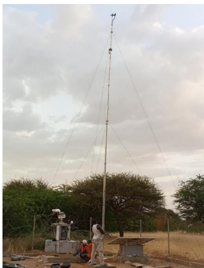
Figure 50: Mât du vent installé capteur de direction du vent orienté vers le nord / Wind mast erected; wind direction sensor orientated to north.
