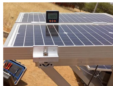
Figure 68: Structure de support PV-S avec un angle d'inclinaison de 18° vers le sud / PV-S support structure with 18° tilt angle towards south.
