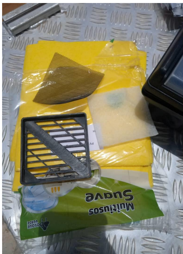
Figure 84: Filtres de l'unité de ventilation après leur remplacement / Ventilation unit filters after replacement.
