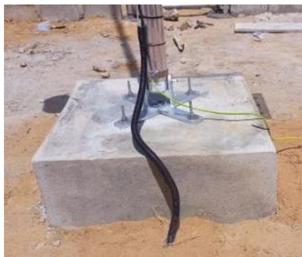
Figure 47: Fondations du mât du vent, câble de terre fixé au boulon de terre, tube de protection pour les câbles du mât du vent / Wind mast foundations, ground cable fixed to ground bolt, protective tube for wind mast cables.
