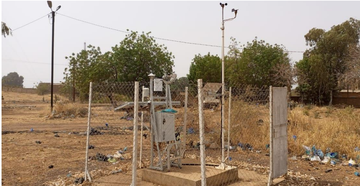
Figure 66: Vue d'ensemble de la station de mesure / Measurement station overview.
