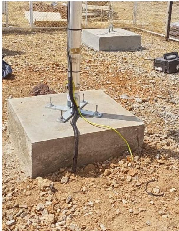
**Figure 12 : Fondations du mât du vent, câble de terre fixé au boulon de terre, tube de protection pour les câbles du mât du vent / Wind mast foundations, ground cable fixed to ground bolt, protective tube for wind mast cables**
