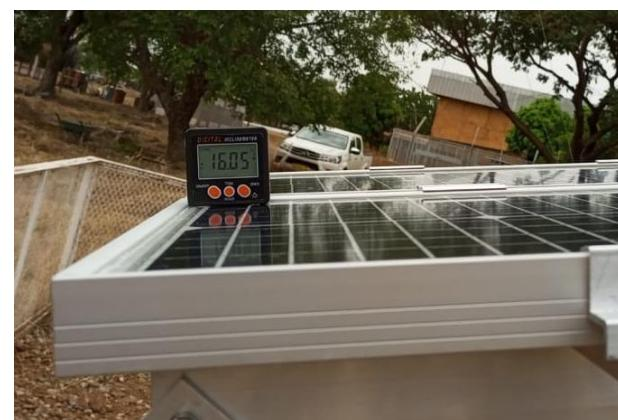
**Figure 33: Structure de support PV-S avec un angle d'inclinaison de 16° vers le sud / PV-S support structure with 16° tilt angle towards South.**
