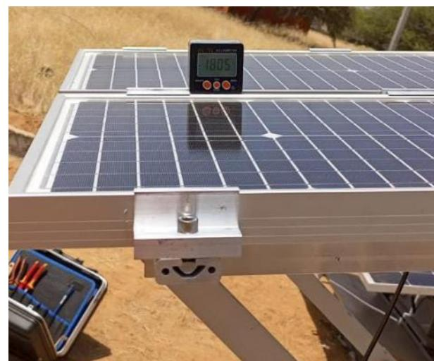
**Figure 33: Structure de support PV-S avec un angle d'inclinaison de 18° vers le sud / PV-S support structure with 18° tilt angle towards South.**
