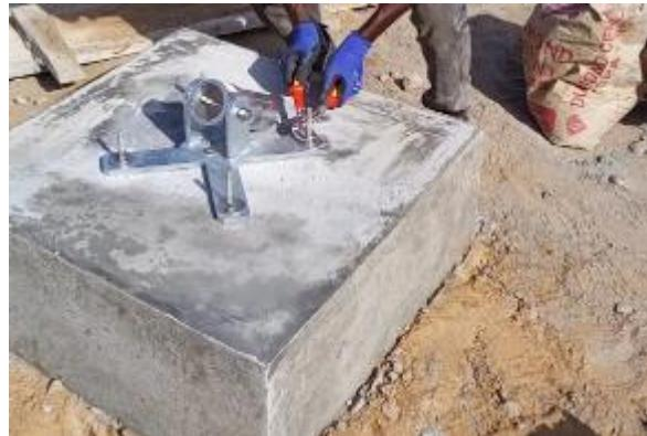
**Figure 10 : Fondations du mât du vent / Wind mast foundations**
