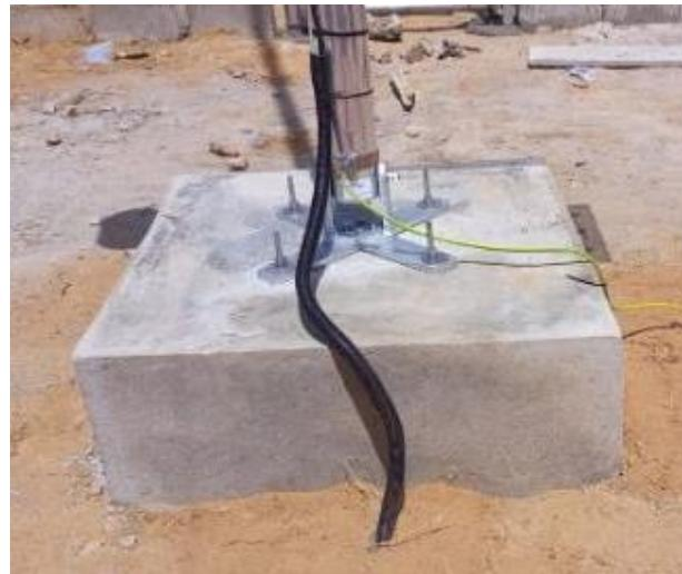
**Figure 12 : Fondations du mât du vent, câble de terre fixé au boulon de terre, tube de protection pour les câbles du mât du vent / Wind mast foundations, ground cable fixed to ground bolt, protective tube for wind mast cables**
