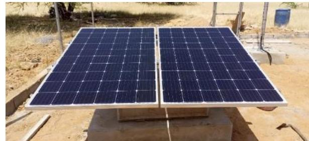
**Figure 35 : Système d'alimentation / Power supply PV system**
