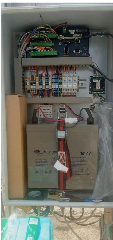
**Figure 56 : Intérieur boîtier de contrôle / Control box interior.**
