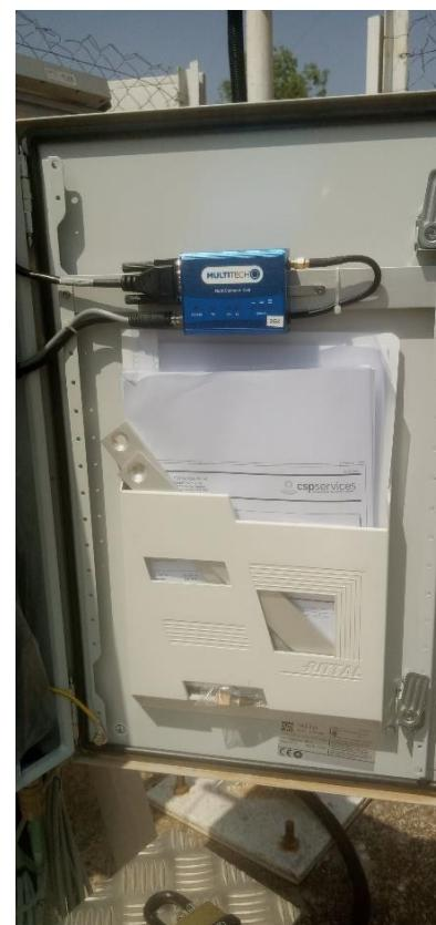
**Figure 57: Porte boîtier de contrôle avec modem GSM / Control box door with GSM modem.**
