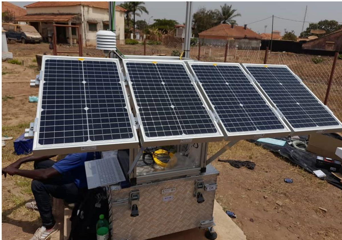
Figure 31: Assemblage de la structure PV-S + modules et modules d'alimentation / Assembly of PV-S structure + modules. and supply modules
