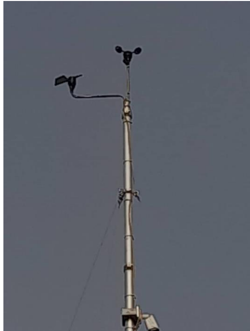
Figure 14: Capteurs de vent installés sur le mât du vent / Wind sensors installed on wind mast
