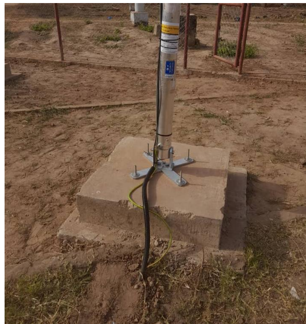
Figure 12 : Fondations du mât du vent, câble de terre fixé au boulon de terre, tube de protection pour les câbles du mât du vent / Wind mast foundations, ground cable fixed to ground bolt, protective tube for wind mast cables
