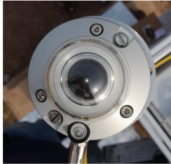
Figure 18: Mise à niveau du pyranomètre CMP10 (GHI) / CMP10 pyranometer leveling (GHI)
