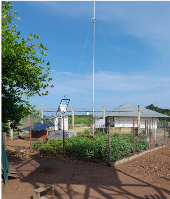
Figure 77: Vue d'ensemble de la station de mesure / Measurement station overview.
