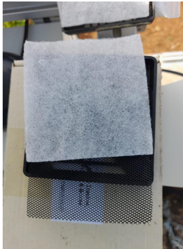
Figure 84: Filtres de l'unité de ventilation après leur remplacement / Ventilation unit filters after replacement.
