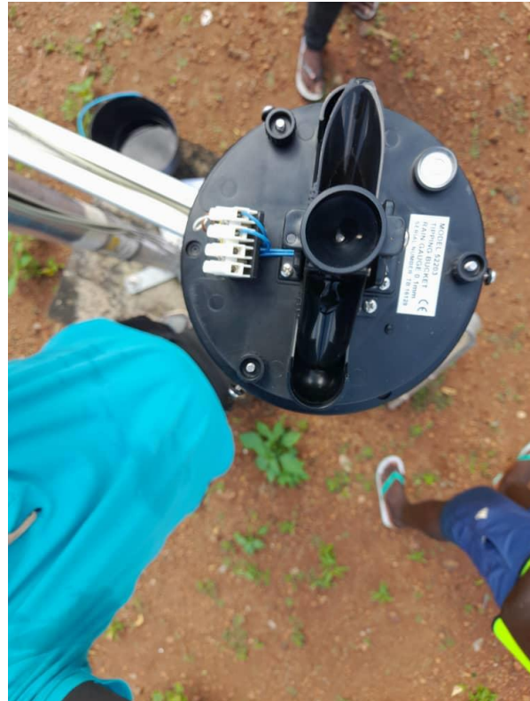
Figure 86: Mise à niveau du capteur de pluie / Rain sensor levelling.
