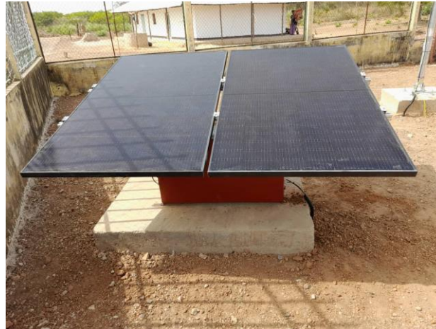
Figure 70 : Système d'alimentation / Power supply PV system.
