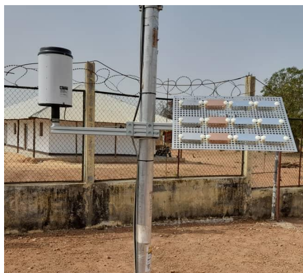
Figure 24: Capteur de pluie et échantillonneur de corrosion / Rain sensor and corrosion sampler
