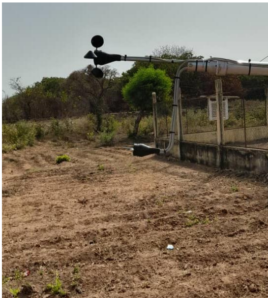
Figure 11: Préparatifs du mât du vent / Wind mast preparations
