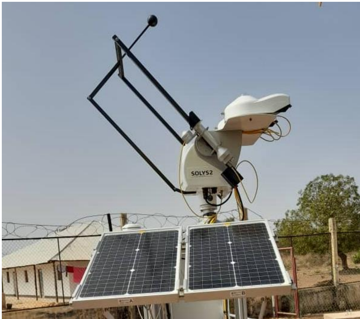
Figure 36 : Tracker solaire, capteurs et panneaux PV du système de mesure de salissure (PV-S) / Solar tracker, sensors and PV panels of soiling measurement system (PV-S).
