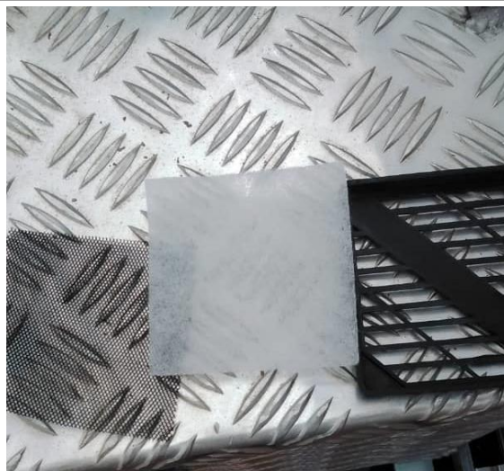
Figure 82: Filtres de l'unité de ventilation après leur remplacement / Ventilation unit filters after replacement.
