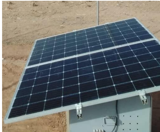
Figure 70 : Système d'alimentation / Power supply PV system.
