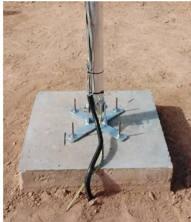
Figure 47 : Fondations du mât du vent, câble de terre fixé au boulon de terre, tube de protection pour les câbles du mât du vent / Wind mast foundations, ground cable fixed to ground bolt, protective tube for wind mast cables.
