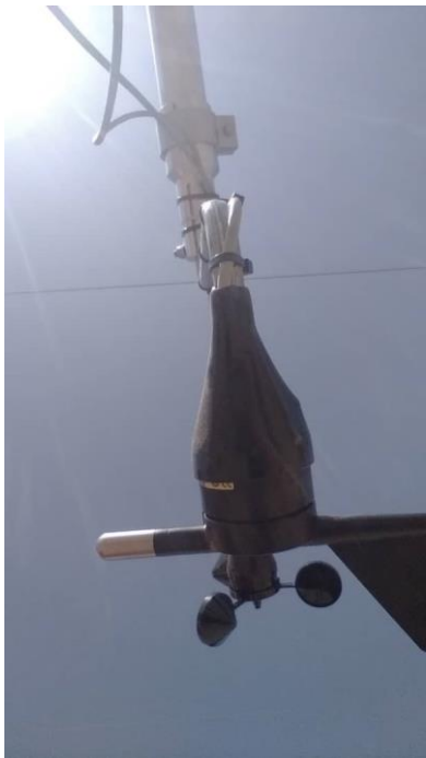
Figure 13: Marque nord du capteur de direction du vent alignée avec le cantilever de montage et la direction du nord. / Wind direction sensor north mark aligned with mounting cantilever and north direction
