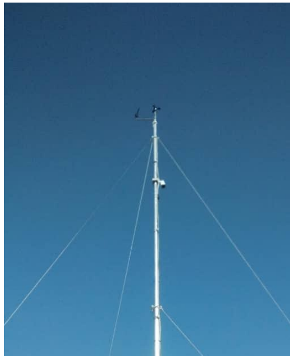
Figure 14: Capteurs de vent installés sur le mât du vent / Wind sensors installed on wind mast
