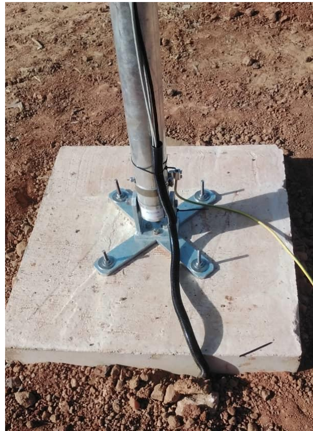
Figure 12 : Fondations du mât du vent, câble de terre fixé au boulon de terre, tube de protection pour les câbles du mât du vent / Wind mast foundations, ground cable fixed to ground bolt, protective tube for wind mast cables
