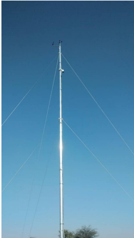
Figure 15: Mât du vent installé capteur de direction du vent orienté vers le nord / Wind mast erected; wind direction sensor orientated to North
