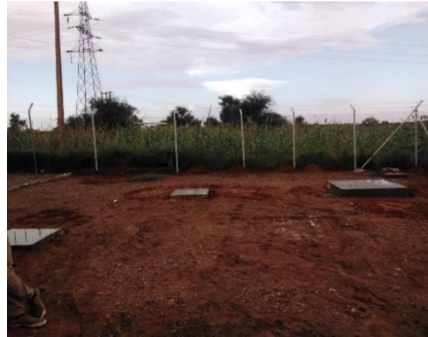
Figure 10 : Fondations du mât du vent / Wind mast foundations
