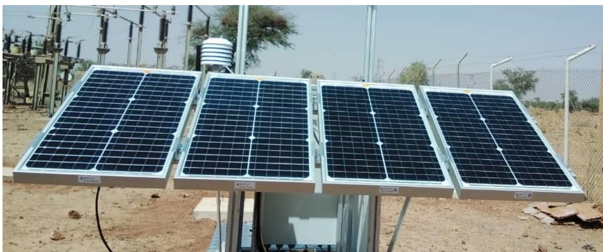
Figure 31: Assemblage de la structure PV-S + modules et modules d'alimentation / Assembly of PV-S structure + modules. and supply modules
