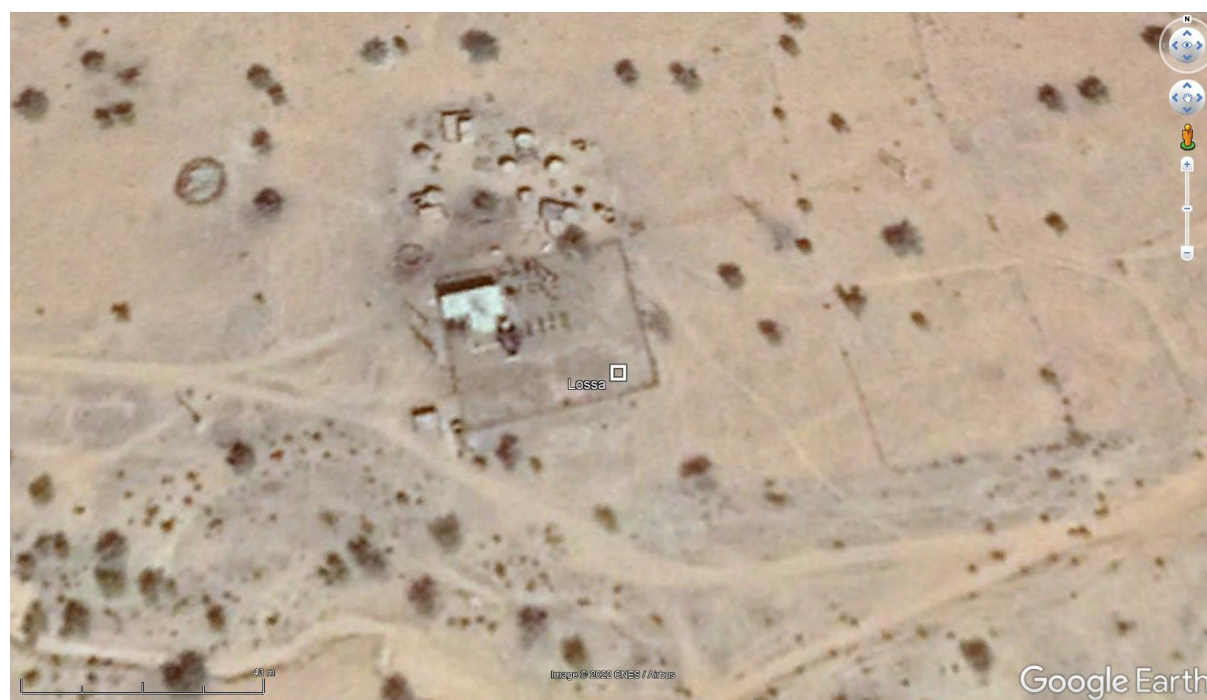
Figure 2: Emplacement dans la sous-station de NIGELEC à Lossa/ Location at the NIGELEC substation in Lossa.
