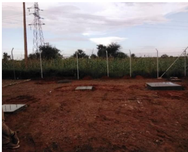
Figure 46 : Fondations du mât du vent / Wind mast foundations.
