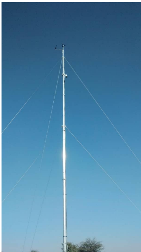
Figure 51: Mât du vent installé capteur de direction du vent orienté vers le nord / Wind mast installed; wind direction sensor orientated to north.
