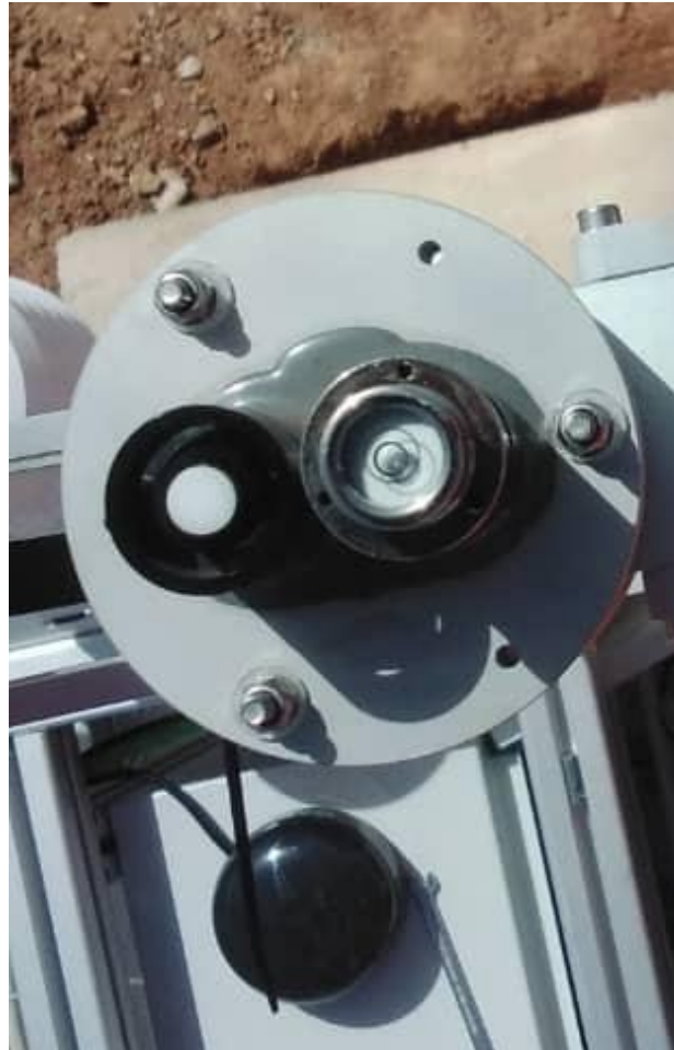
Figure 58 : Mise à niveau du PU / PU unit leveling.
