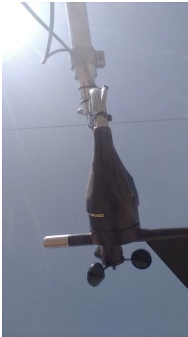
Figure 49: Marque nord du capteur de direction du vent alignée avec le cantilever de montage et la direction du nord. / Wind direction sensor north mark aligned with mounting cantilever and north direction.
