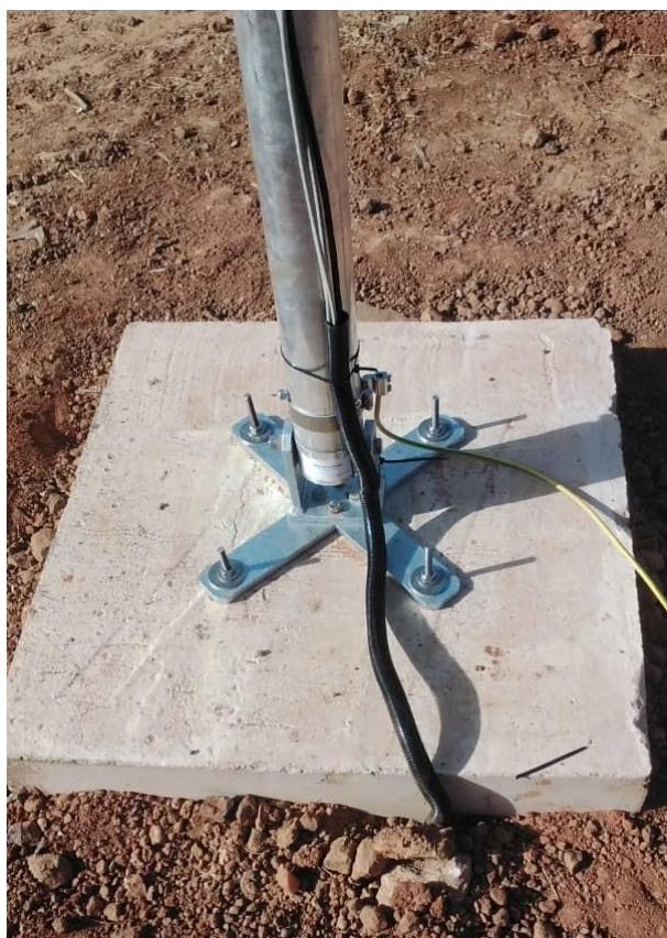
Figure 48 : Fondations du mât du vent, câble de terre fixé au boulon de terre, tube de protection pour les câbles du mât du vent / Wind mast foundations, ground cable fixed to ground bolt, protective tube for wind mast cables.
