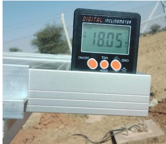
Figure 69: Structure de support PV-S avec un angle d'inclinaison de 18° vers le sud / PV-S support structure with 18° tilt angle towards south.
