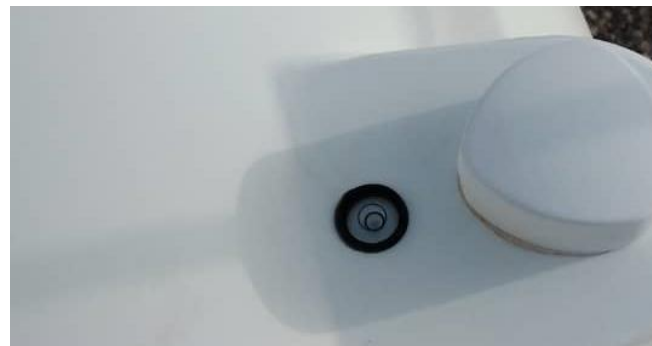
Figure 20: Mise à niveau du tracker / Tracker leveling
