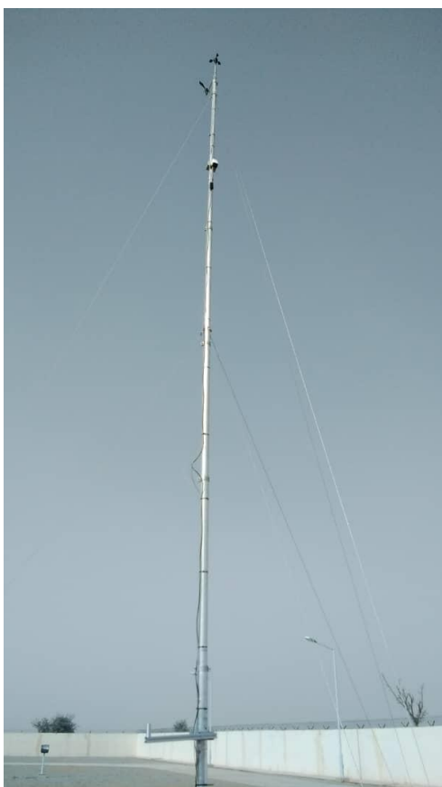
Figure 15: Mât du vent installé capteur de direction du vent orienté vers le nord / Wind mast erected; wind direction sensor orientated to North
