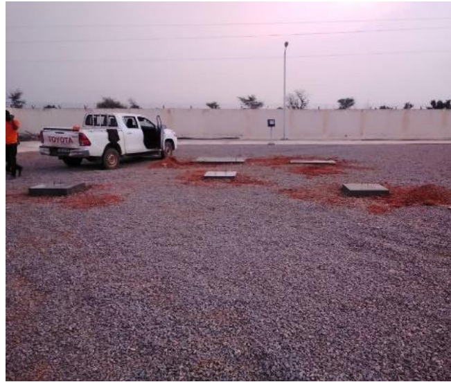
Figure 10 : Fondations du mât du vent / Wind mast foundations
