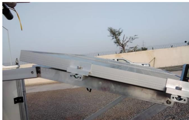
Figure 33: Structure de support PV-S avec un angle d'inclinaison de 18° vers le sud / PV-S support structure with 18° tilt angle towards South.
