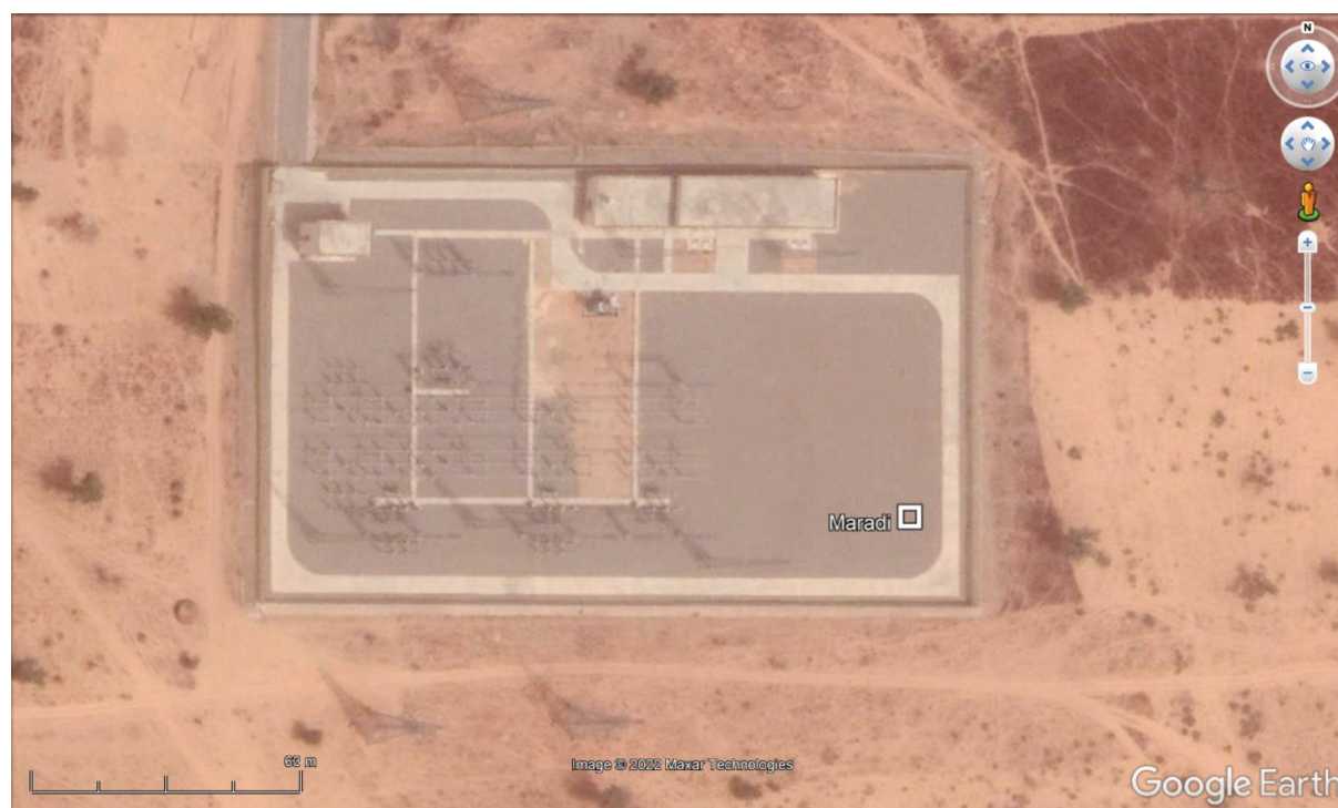
Figure 2: Emplacement dans la sous-station de NIGELEC à Maradi / Location at the NIGELEC substation in Maradi.
