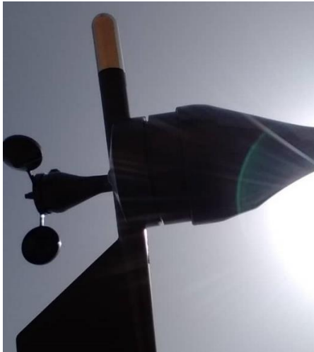
Figure 13: Marque nord du capteur de direction du vent alignée avec le cantilever de montage et la direction du nord. / Wind direction sensor north mark aligned with mounting cantilever and north direction
