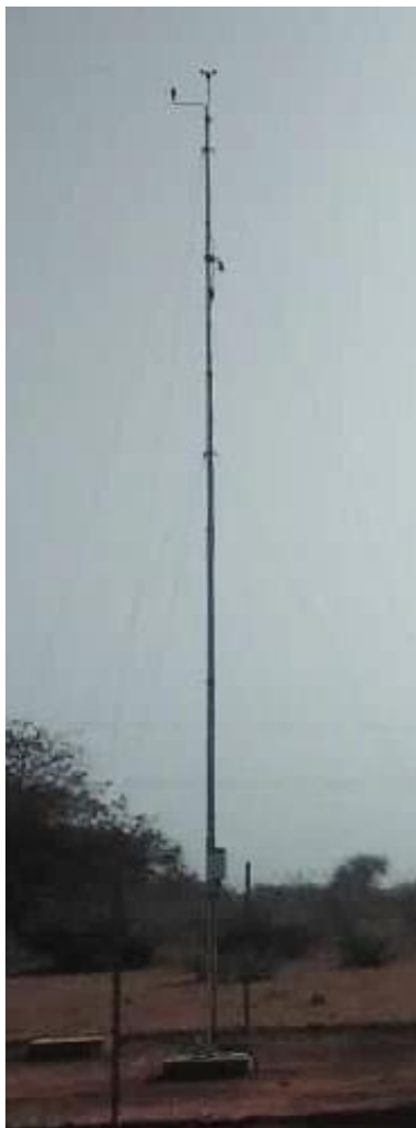
Figure 15: Mât du vent installé capteur de direction du vent orienté vers le nord / Wind mast erected; wind direction sensor orientated to North
