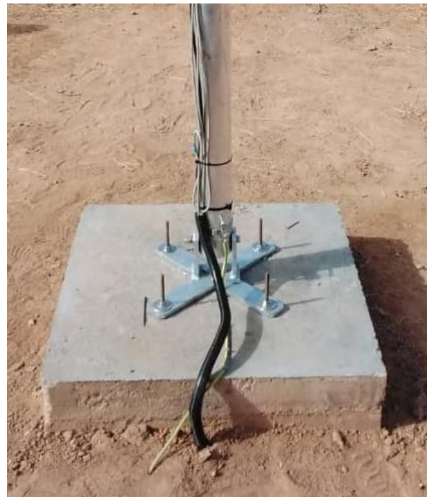
Figure 12 : Fondations du mât du vent, câble de terre fixé au boulon de terre, tube de protection pour les câbles du mât du vent / Wind mast foundations, ground cable fixed to ground bolt, protective tube for wind mast cables
