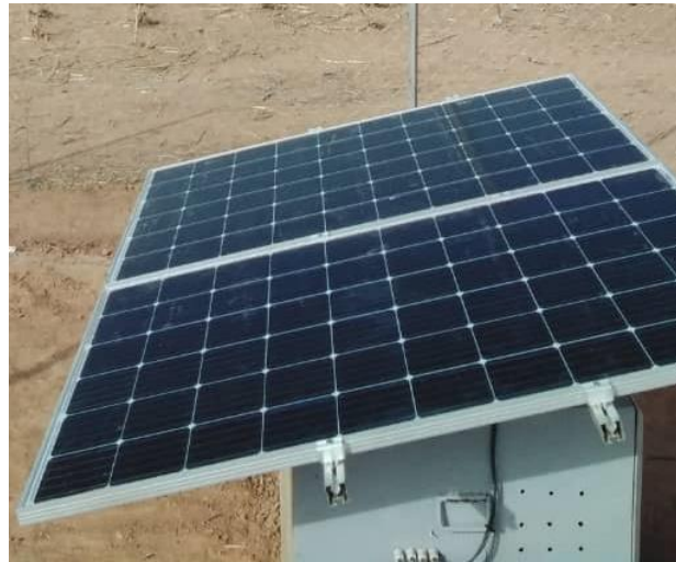
Figure 35 : Système d'alimentation / Power supply PV system
