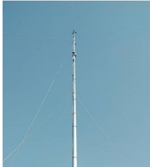
Figure 14: Capteurs de vent installés sur le mât du vent / Wind sensors installed on wind mast
