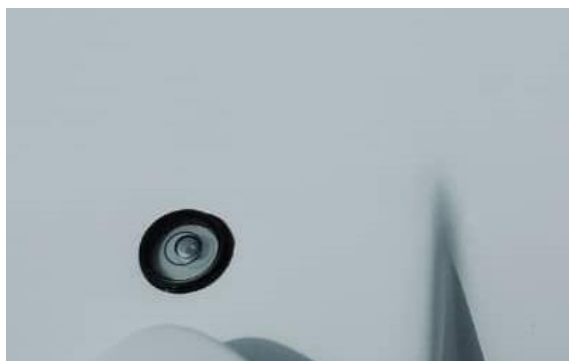
Figure 20: Mise à niveau du tracker / Tracker leveling
