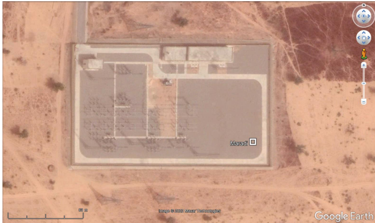
Figure 3: Emplacement dans la sous-station de la NIGELEC en Maradi / Location at the NIGELEC substation in Maradi.
