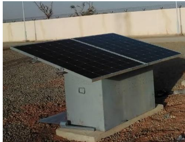
Figure 70 : Système d'alimentation / Power supply PV system.
