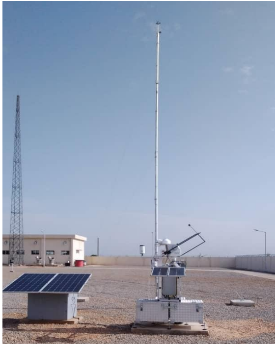
Figure 77: Vue d'ensemble de la station de mesure / Measurement station overview.
