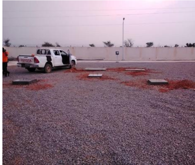
Figure 45 : Fondations du mât du vent / Wind mast foundations.
