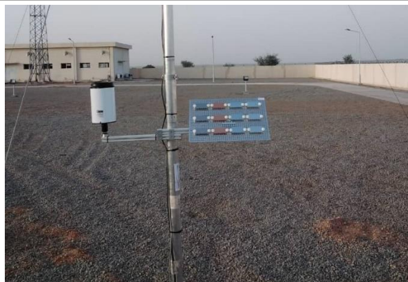
Figure 59: Capteur de pluie et échantillonneur de corrosion / Rain sensor and corrosion sampler.
