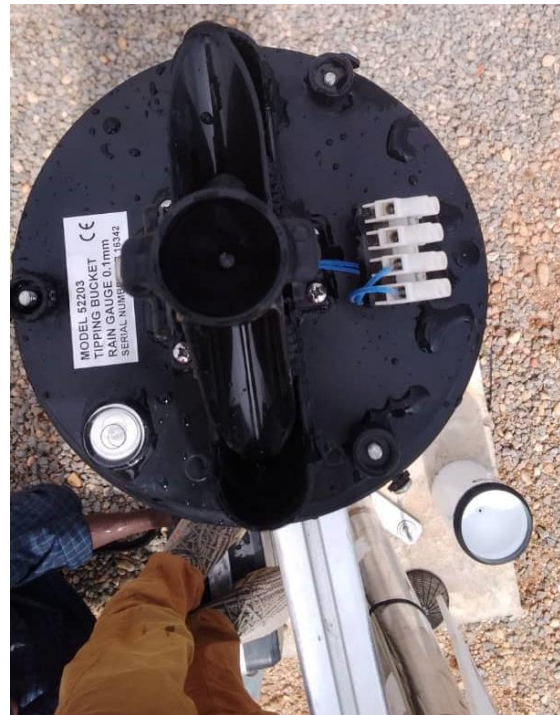
Figure 86: Mise à niveau du capteur de pluie / Rain sensor levelling.
