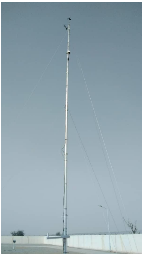
Figure 50: Mât du vent installé capteur de direction du vent orienté vers le nord / Wind mast erected; wind direction sensor orientated to north.
