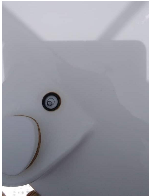
Figure 80: Mise à niveau du tracker / Tracker leveling.
