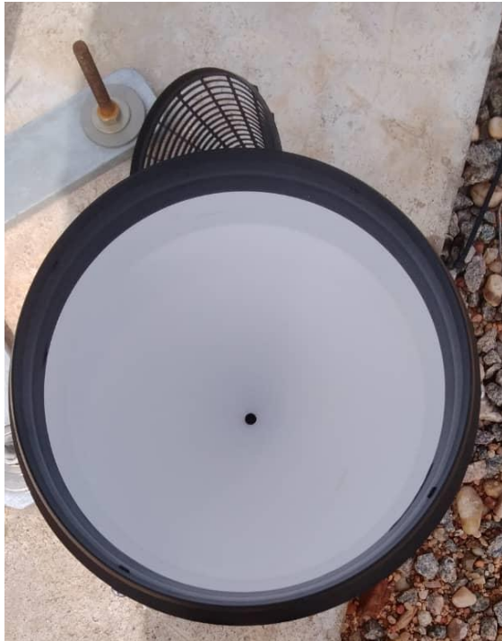
Figure 85: Nettoyage du capteur de pluie / Rain sensor cleaning.
