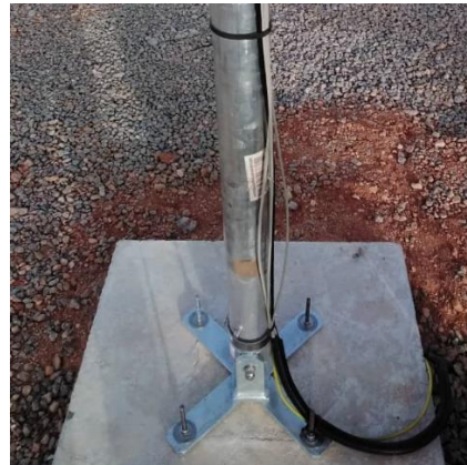
Figure 47 : Fondations du mât du vent, câble de terre fixé au boulon de terre, tube de protection pour les câbles du mât du vent / Wind mast foundations, ground cable fixed to ground bolt, protective tube for wind mast cables.
