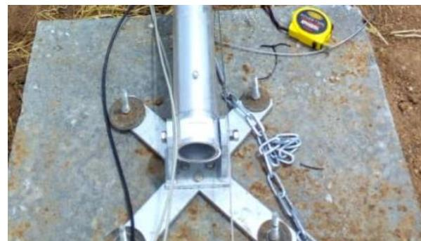
**Figure 12 : Fondations du mât du vent, câble de terre fixé au boulon de terre, tube de protection pour les câbles du mât du vent / Wind mast foundations, ground cable fixed to ground bolt, protective tube for wind mast cables**
