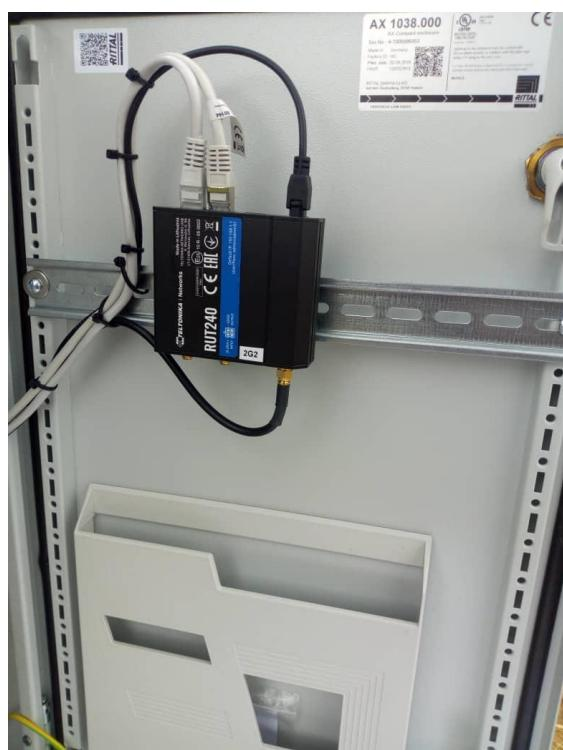
**Figure 31: Ruteur LTE 7 LTE router**
