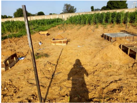
Figure 9: Clôture et fondation / Fence and foundation
