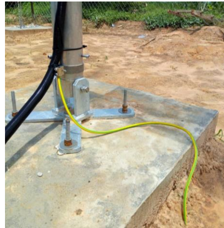
Figure 12 : Fondations du mât du vent, câble de terre fixé au boulon de terre, tube de protection pour les câbles du mât du vent / Wind mast foundations, ground cable fixed to ground bolt, protective tube for wind mast cables
