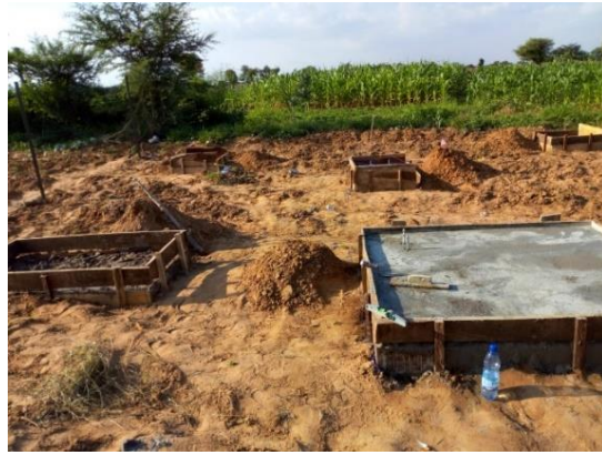
Figure 10 : Fondations de la station et du mât du vent / Station and wind mast foundations
