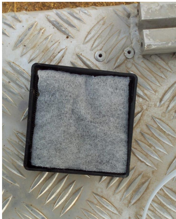
Figure 83: Filtres de l'unité de ventilation après leur remplacement / Ventilation unit filters after replacement.
