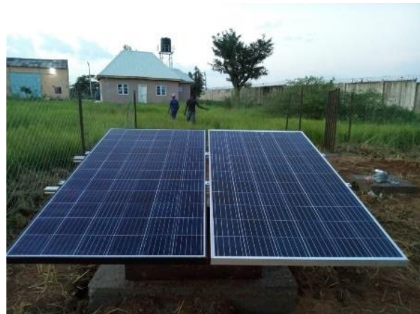
Figure 70 : Système d'alimentation / Power supply PV system.
