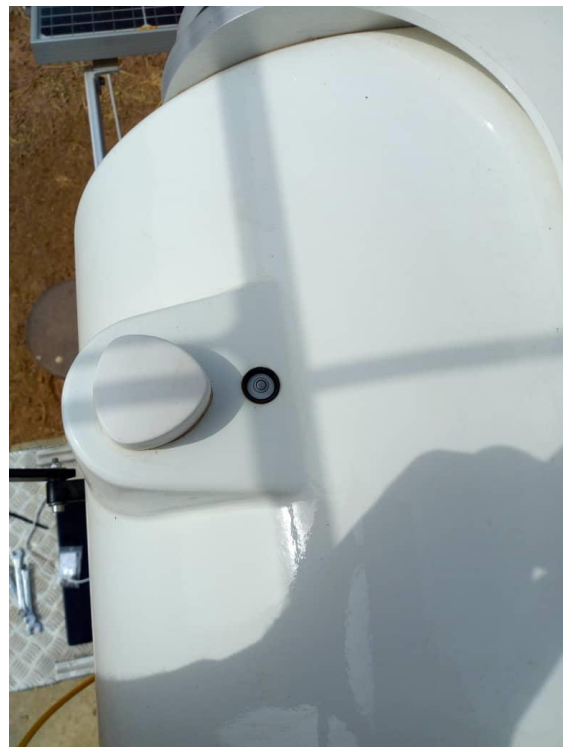
Figure 79: Mise à niveau du tracker / Tracker leveling.
