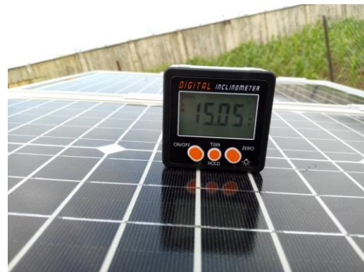
Figure 68: Structure de support PV-S avec un angle d'inclinaison de 15° vers le sud / PV-S support structure with 15° tilt angle towards south.
