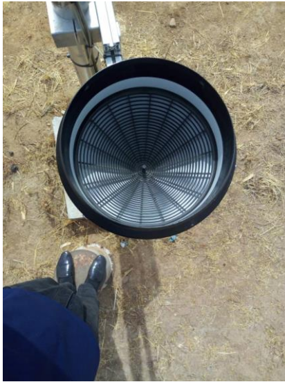
Figure 84: Intérieur du boîtier de contrôle / Rain sensor cleaning.
