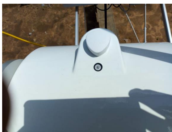
Figure 55: Mise à niveau du tracker / Tracker leveling.
