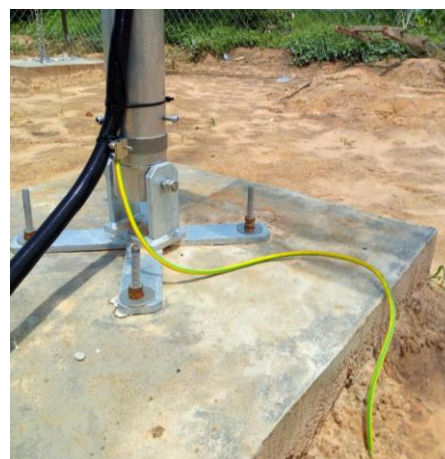
Figure 47 : Fondations du mât du vent, câble de terre fixé au boulon de terre, tube de protection pour les câbles du mât du vent / Wind mast foundations, ground cable fixed to ground bolt, protective tube for wind mast cables.
