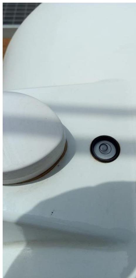
Figure 83: Mise à niveau du tracker / Tracker leveling.
