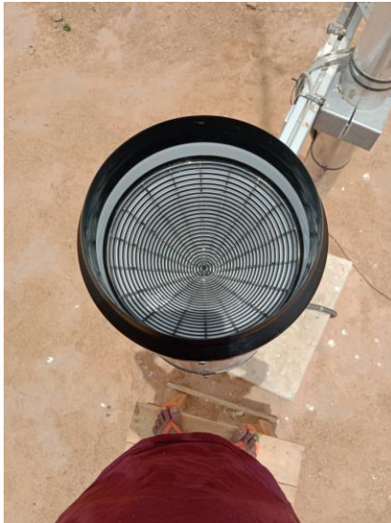
Figure 88: Nettoyage du capteur de pluie / Rain sensor cleaning.
