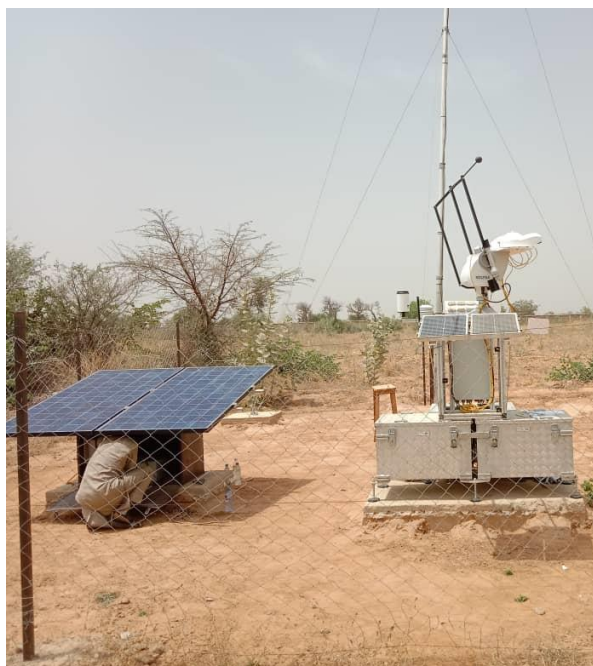
Figure 80: Vue d'ensemble de la station de mesure / Measurement station overview.
