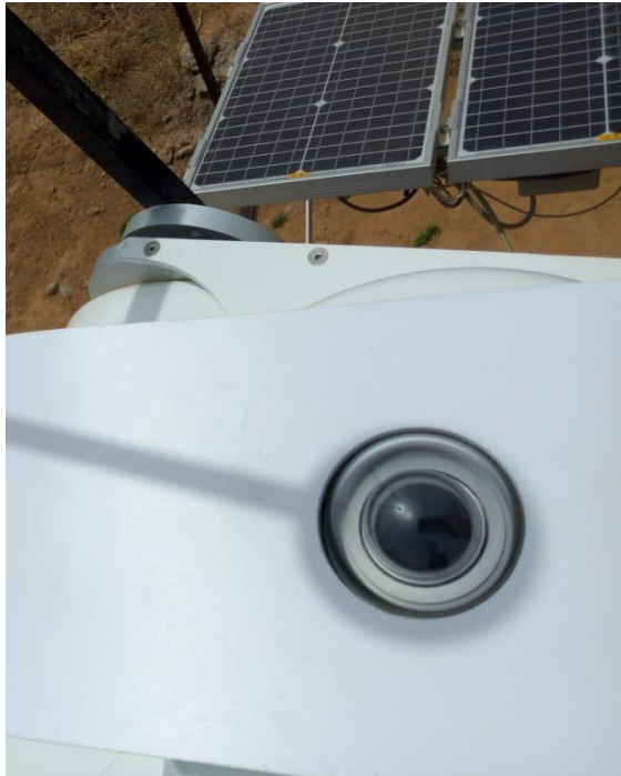
Figure 84: Alignement de l'assemblage de l'ombrage / Shading assembly alignment.
