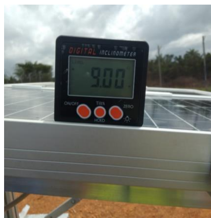
Figure 33: Structure de support PV-S avec un angle d'inclinaison de 9° vers le sud / PV-S support structure with 9° tilt angle towards South.
