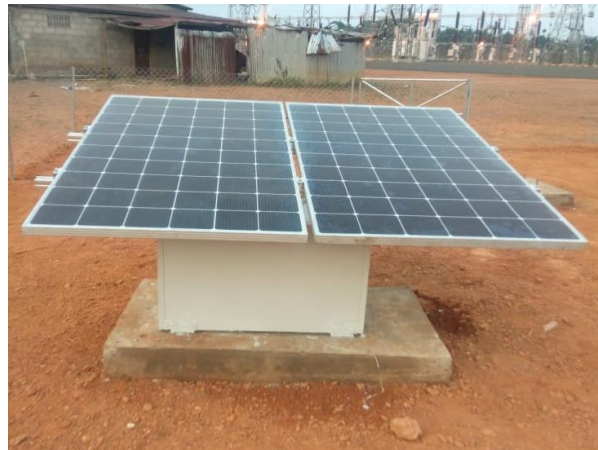
Figure 35 : Système d'alimentation / Power supply PV system
