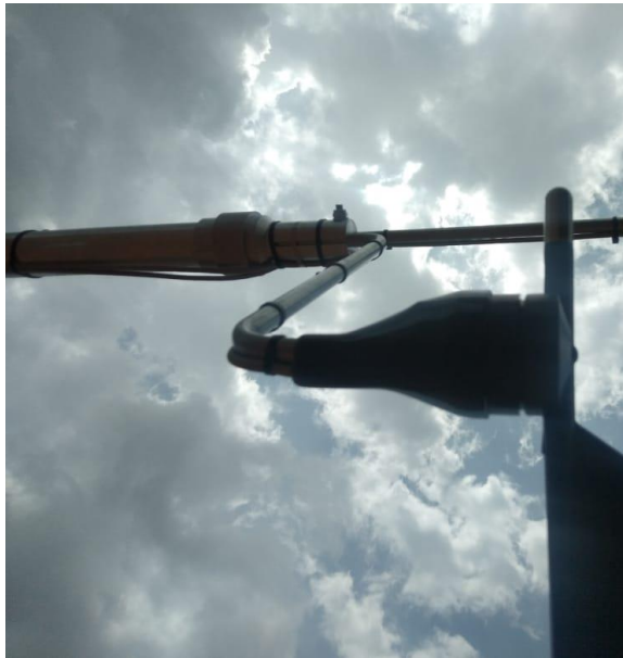
Figure 13: Marque nord du capteur de direction du vent alignée avec le cantilever de montage et la direction du nord. / Wind direction sensor north mark aligned with mounting cantilever and north direction
