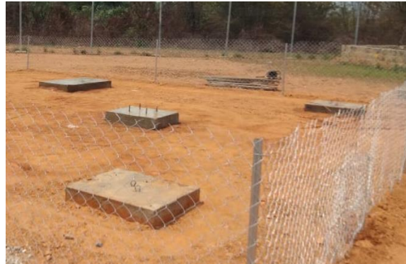
Figure 10 : Fondations du mât du vent / Wind mast foundations
