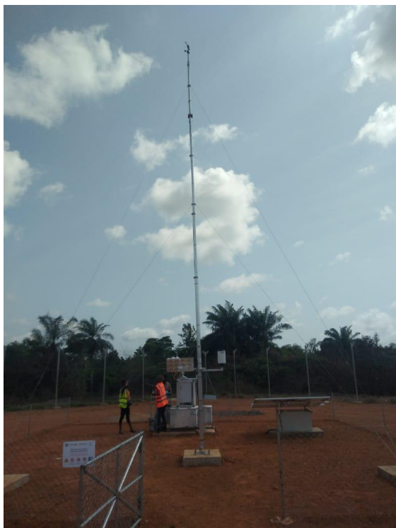
Figure 15: Mât du vent installé capteur de direction du vent orienté vers le nord / Wind mast erected; wind direction sensor orientated to North
