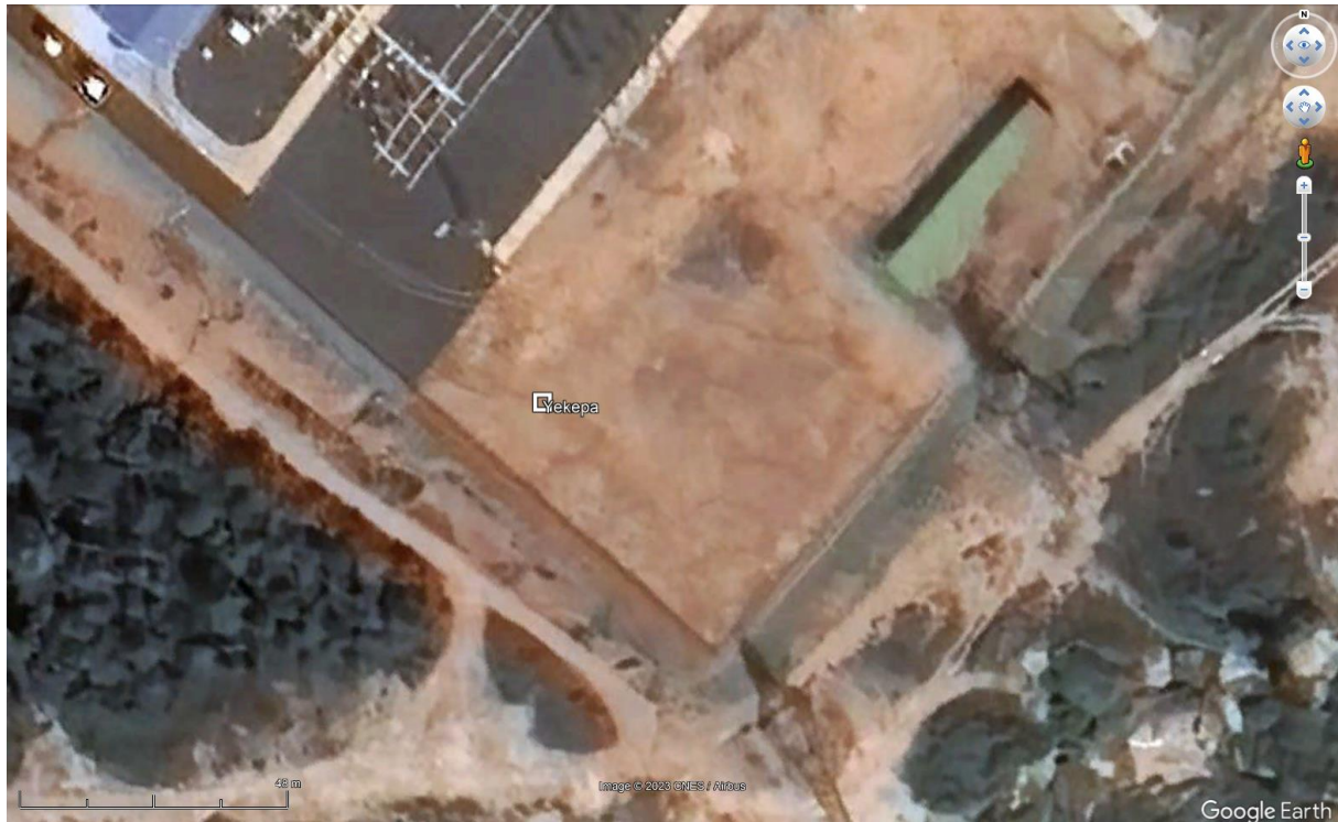
Figure 4: Emplacement dans la sous-station de TRANSCO CLSG (il n'y a pas encore d'images récentes disponibles sur Google Earth pour voir la station météorologique) / Location at the TRANSCO CLSG substation in Yekepa (there are not yet any recent images on Google Earth available to see the weather station).
