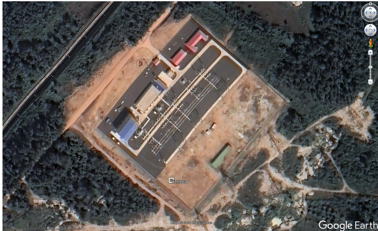
Figure 3: Emplacement dans la sous-station de TRANSCO CLSG à Yekepa / Location at the TRANSCO CLSG substation in Yekepa.
