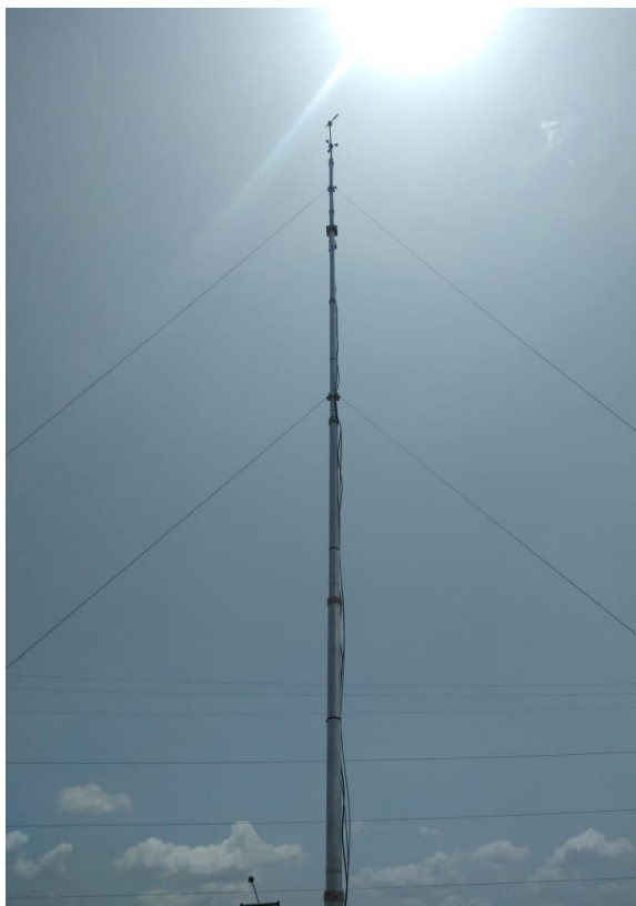
Figure 50: Mât du vent installé capteur de direction du vent orienté vers le nord / Wind mast erected; wind direction sensor orientated to north.
