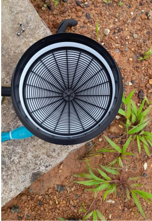
Figure 83: Nettoyage du capteur de pluie / Rain sensor cleaning.
