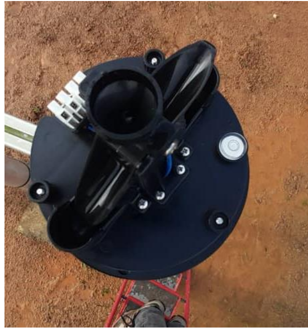
Figure 84: Mise à niveau du capteur de pluie / Rain sensor levelling.
