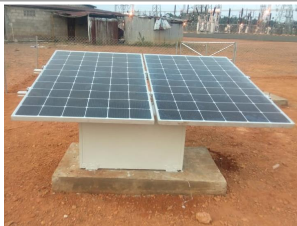
Figure 70 : Système d'alimentation / Power supply PV system
