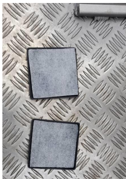
Figure 82: Filtrés de l'unité de ventilation après leur remplacement / Ventilation unit filters after replacement.
