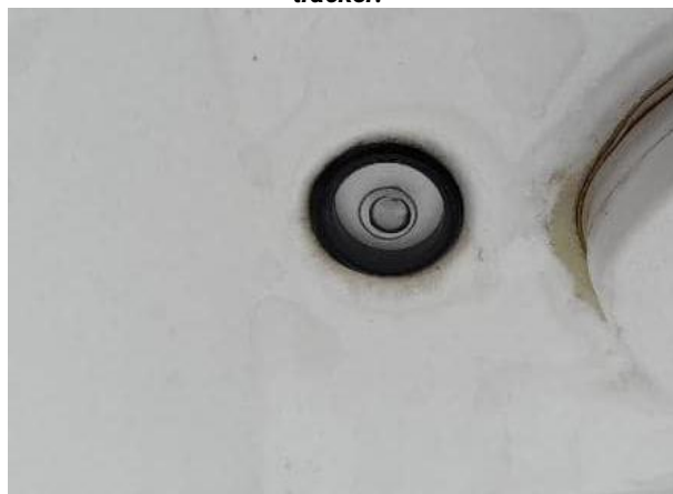
Figure 80: Mise à niveau du tracker / Tracker leveling.
