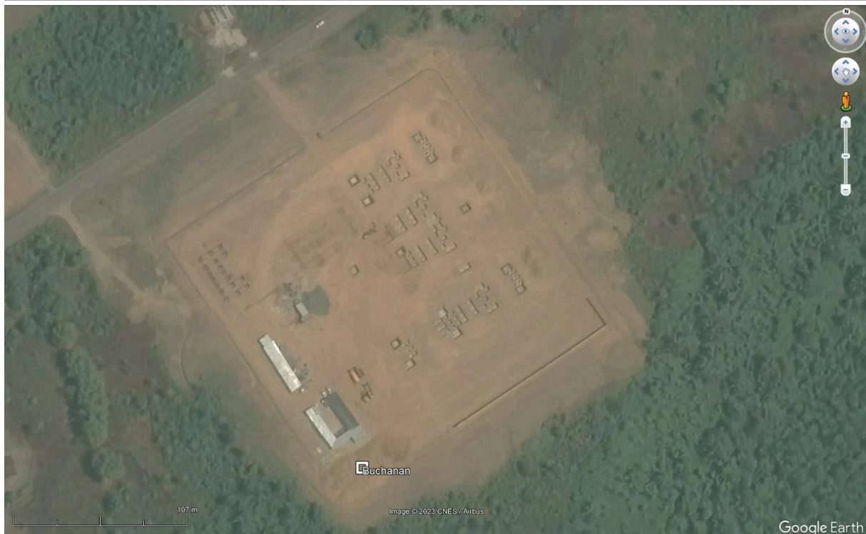
Figure 4: Emplacement dans la sous-station de TRANSCO CLSG (il n'y a pas encore d'images récentes disponibles sur Google Earth pour voir la station météorologique) / Location at the TRANSCO CLSG substation in Buchanan (there are not yet any recent images on Google Earth available to see the weather station).
