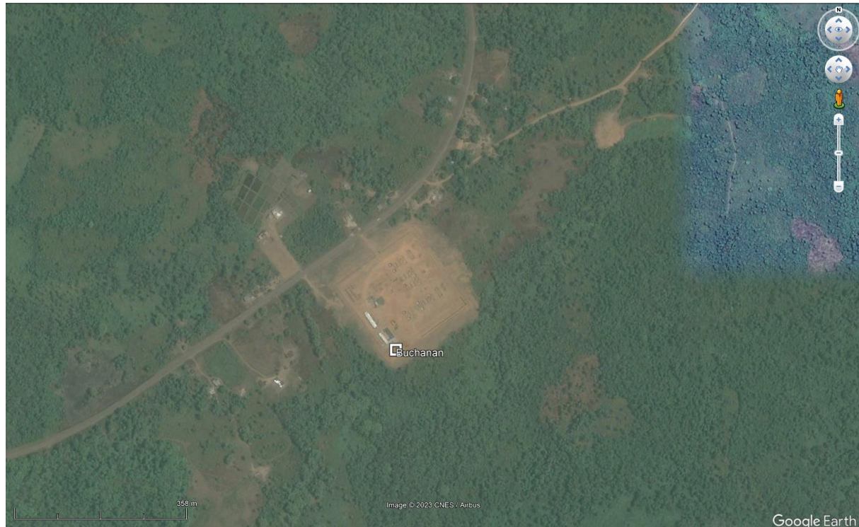
Figure 3: Emplacement dans la sous-station de TRANSCO CLSG à Buchanan / Location at the TRANSCO CLSG substation in Buchanan.
