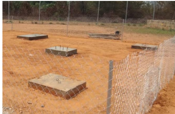
Figure 45 : Fondations du mât du vent / Wind mast foundations.
