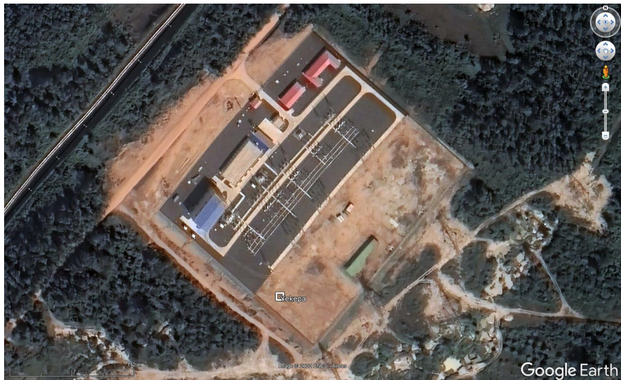
Figure 2: Emplacement dans la sous-station de TRANSCO CLSG à Yekepa / Location at the TRANSCO CLSG substation in Yekepa.
