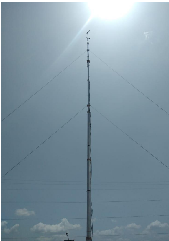
Figure 15: Mât du vent installé capteur de direction du vent orienté vers le nord / Wind mast erected; wind direction sensor orientated to North
